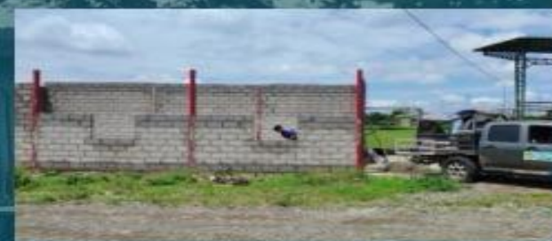
CONSTRUCCION DE CNH CIELITO DE TERNURA
