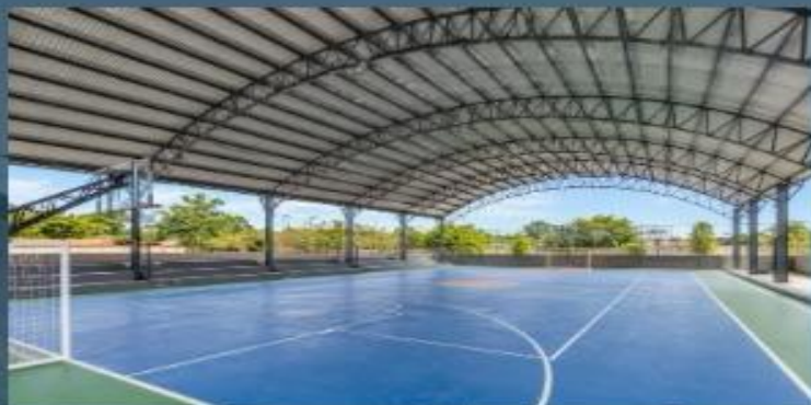
CUBIERTA METÁLICA COLISEO DE DEPORTES GUAYAS
