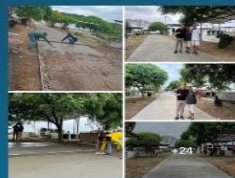
CONSTRUCCIÓN CAMINERA CEMENTERIO RCTO CARLOS JULIO
