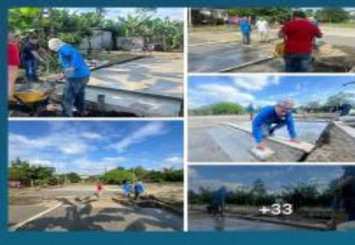
CONSTRUCCIÓN CANCHA DE VOLEY RCTO. MARAÑÓN
