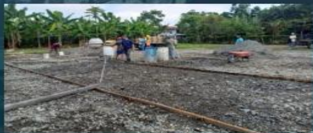
CONSTRUCCIÓN DE CANCHA RECINTO EL ROSARIO
