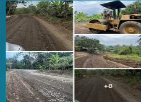
MEJORAMIENTO VIAL SECTOR LA Y - CEMENTERIO
