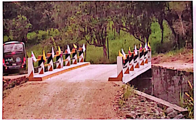
Construcción del Puente Peñas
