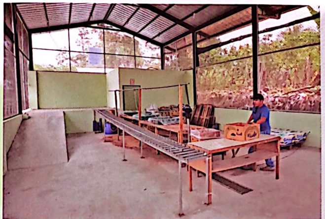
Construcción y equipamiento del Centro de Acopio de Plátano en la Comuna Nuevo Israel
