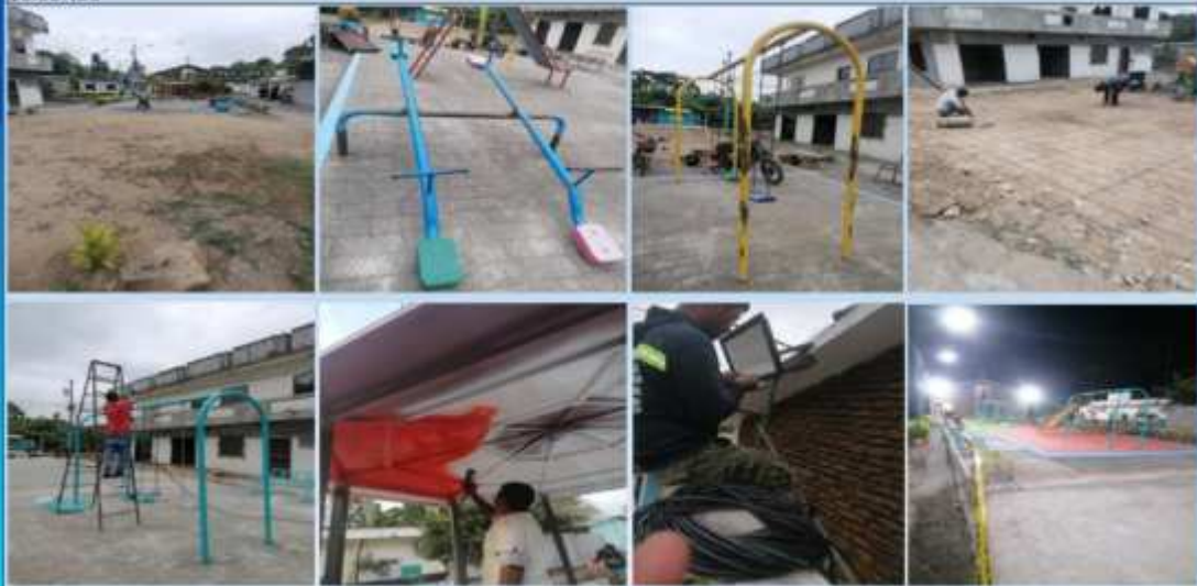
MANTENIMIENTO, REPARACIONES Y ADECUACIONES DEL PARQUE DEL RECINTO, VUELTA LARGA DE LA PARROQUIA YAGUACHI VIEJO CONE. $6.627,00
