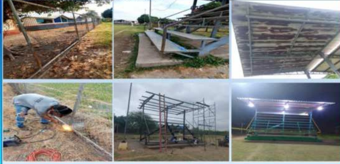
MANTENIMIENTO Y REPARACIONES DE CERRAMIENTO, GRADA, COLOCACIÓN DE BREAKER Y CAMBIO DE CABLEADO E ILUMINACIÓN DE LA CANCHA DE FUTBOL DEL RECINTO SANTA ROSA DDS. $6.627,00
